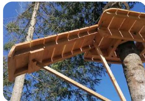
Avec une liaison articulée permettant de réduire les contraintes sur la plateforme et la pression sur le tronc.
